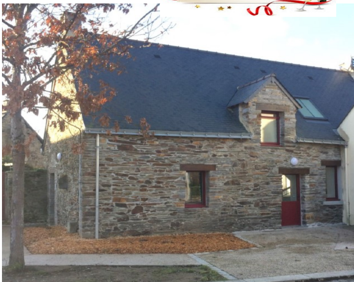
Le logement locatif et le local associatif de la "Maison Gaby"
